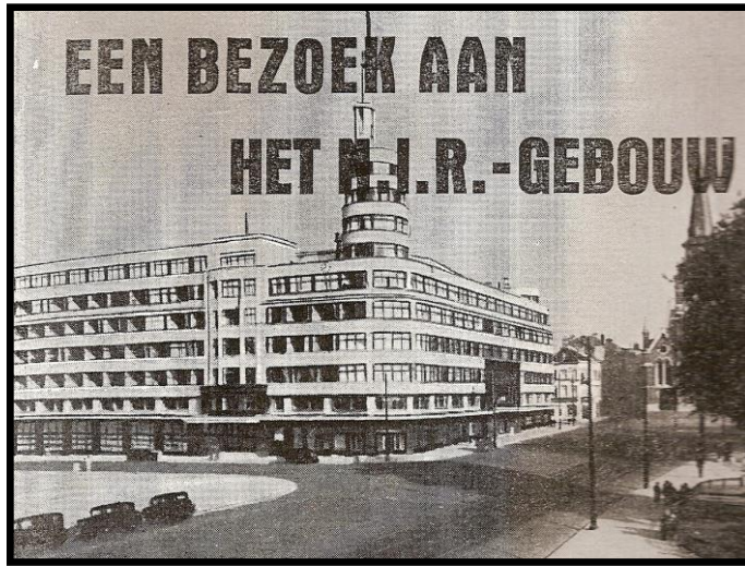
Foto van het Flagey gebouw te Elsene (Ixelles-Brussel) van de hand van de Ukkelse architect Joseph Diongre. De centrale toren omvatte maar liefst negentien studio's. Op vlak van geluidsisolatie behoorde het toen tot de top in Europa. De vormgeving was typische Art-Deco, met een knipoogje naar de zeevaart (Oceaanstomer).
