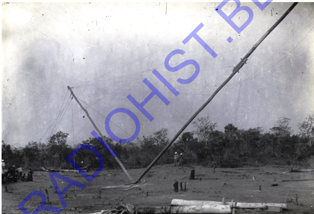
Afb. B1-3 De hulpmast (links) wordt naar omlaag getrokken. Hij is door kabels aan de hoofdmast (rechts) bevestigd. Zo wordt deze in verticale stand gebracht. De hele operatie wordt mede geleid door de overige kabels. Kongolo, 1912.
