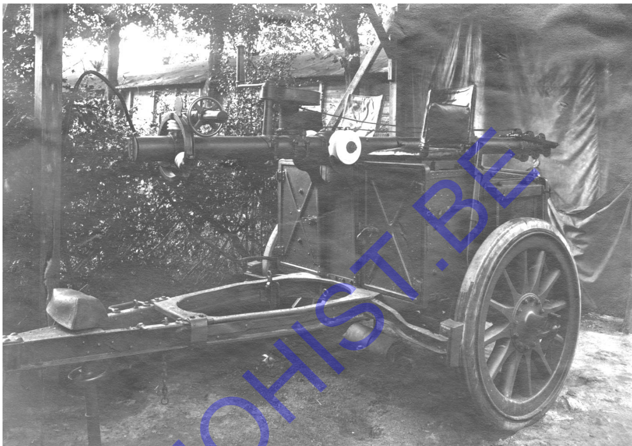
Afb. 14-20 Aanhangwagen van Post D, met de telescopische mast voor de antenne en twee zitjes.
