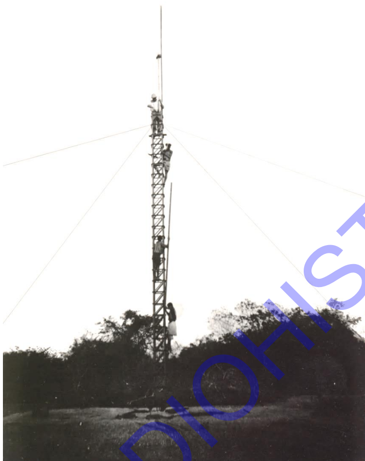
Afb. 12-13 Opbouw antennemast te Lukuga.
