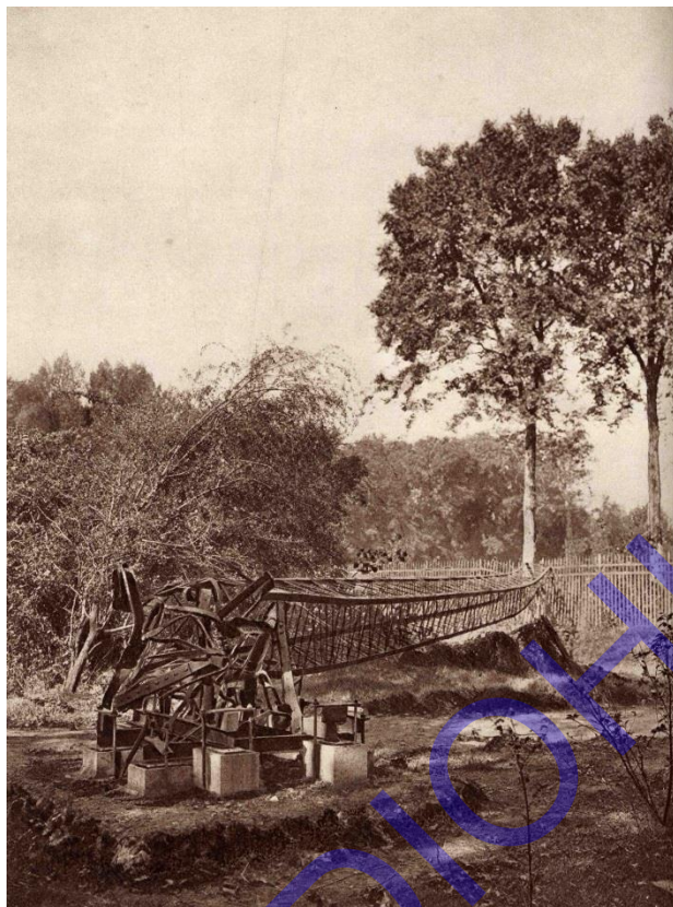
Afb. 7-26 De afbraak van een antennemast.
