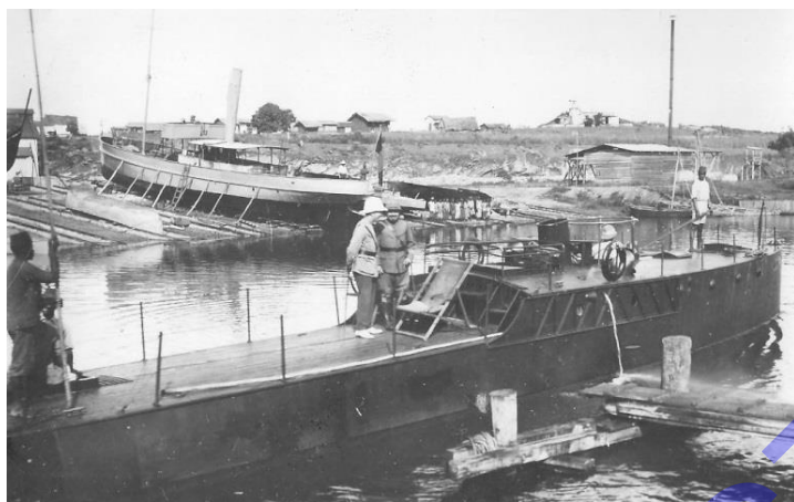
Afb. 3-5 De Netta, door de oorlog bestemd voor de campagne op het Tanganyikameer. Ze kreeg een bewapening die bestond uit een kanon van 37 mm en een mitrailleur.
