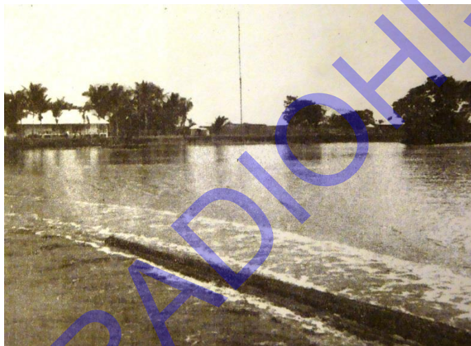
Afb. 2-11 Op de achtergrond ziet men nog de mast van Banana. Op de voorgrond wordt een mast naar Ambrizette over zee op sleeptouw genomen.
