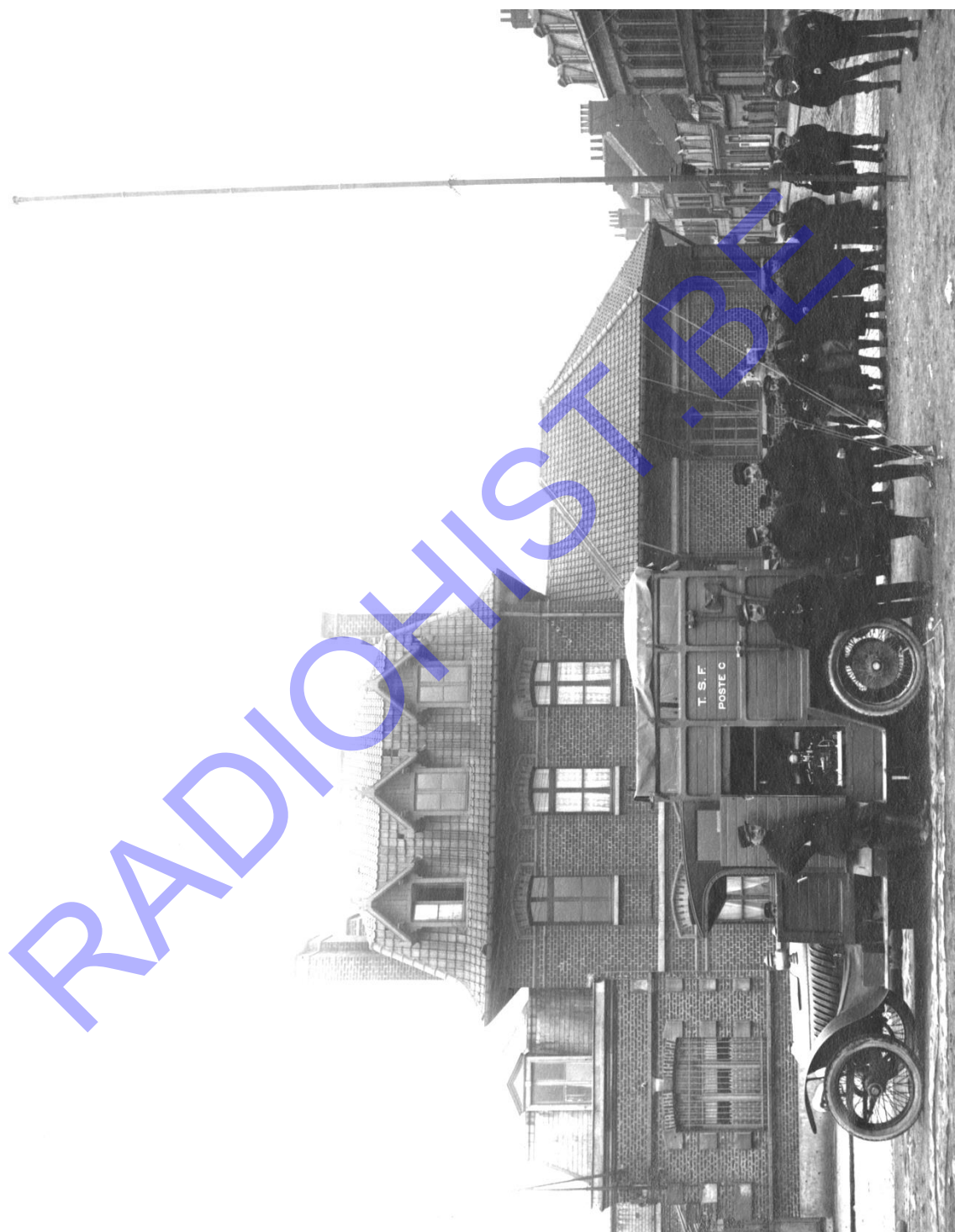
Afb. 11-1 T.S.F.-post C, met Marconizender 1,5 kW en opgestelde antenne te Calais, februari 1916.
