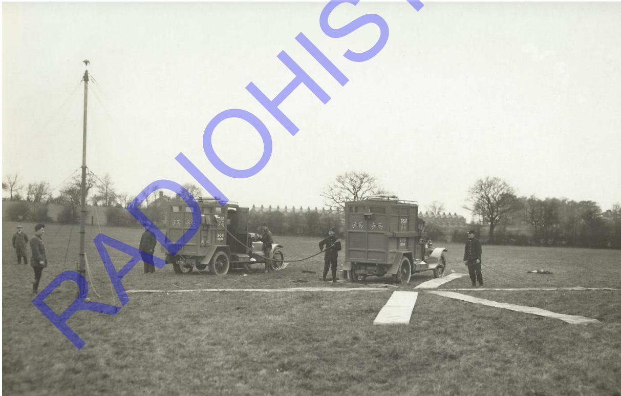
Afb. 11-6 Mobiele T.S.F.-post. Van links naar rechts: Antenne, bedrijfswagen voor stroomvoorziening, wagen met zender-ontvanger. Vooraan bevindt zich de stervormige aardverbinding. Links van de zendmast staat Brailard.
