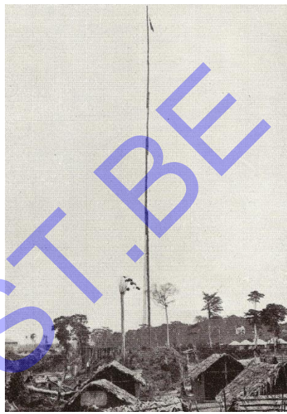
Art. 4-22 De post van Kindu, met een mast van 65 m, ondersteund door 20 kabels van 8 mm.
