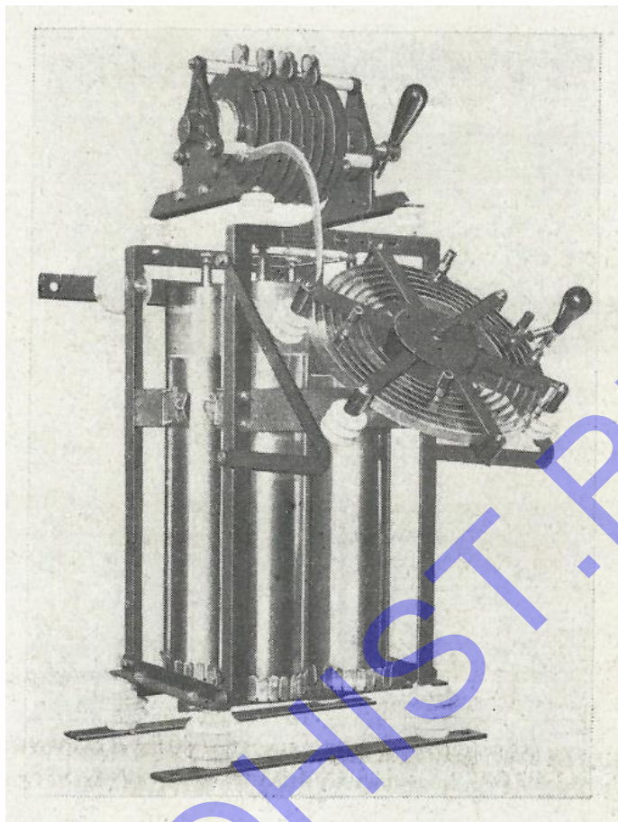
Afb. 4-10 De 1,5 TK van Telefunken : boven de Wiense vonkenbrug, daaronder de Leidse flessen en de koppelingsspiraal. Gesellschaft für drahtlose Telegraphie m.b.h. System "Telefunken", 1904.
