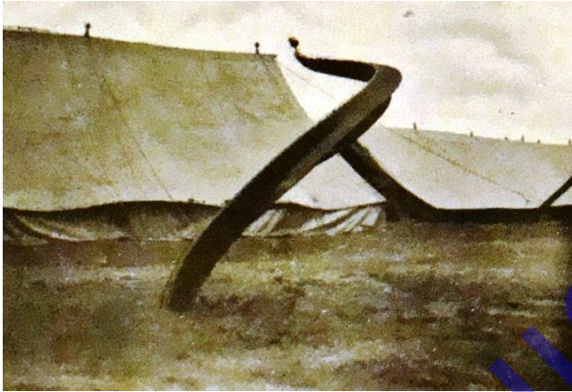
Afb. 4-2 Paal verwrongen door olifanten.
