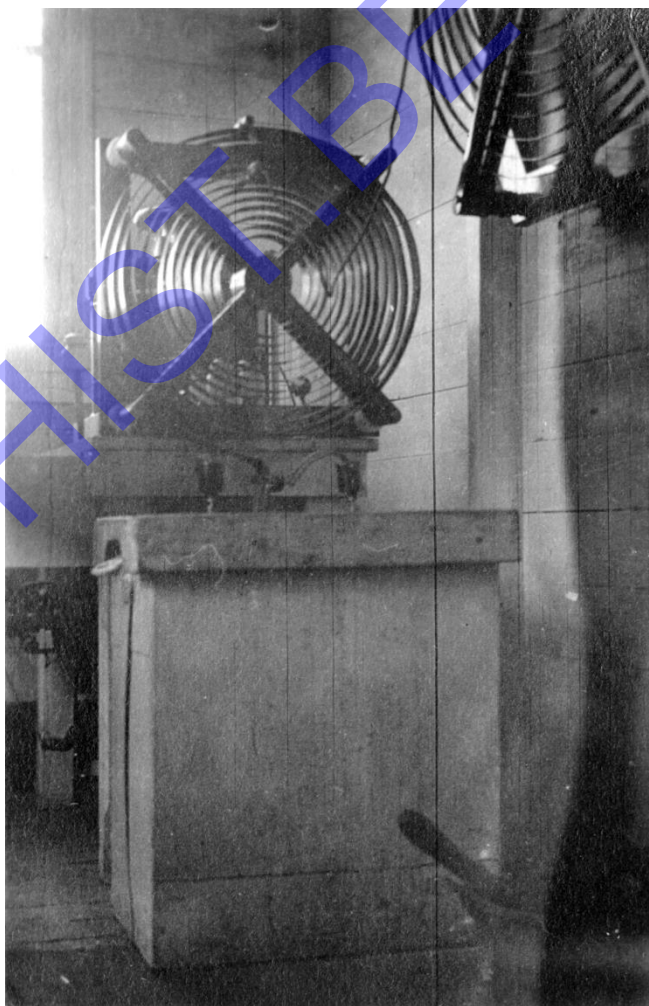
Afb. 13-6 Zender : oscillator- en antennespoel.
