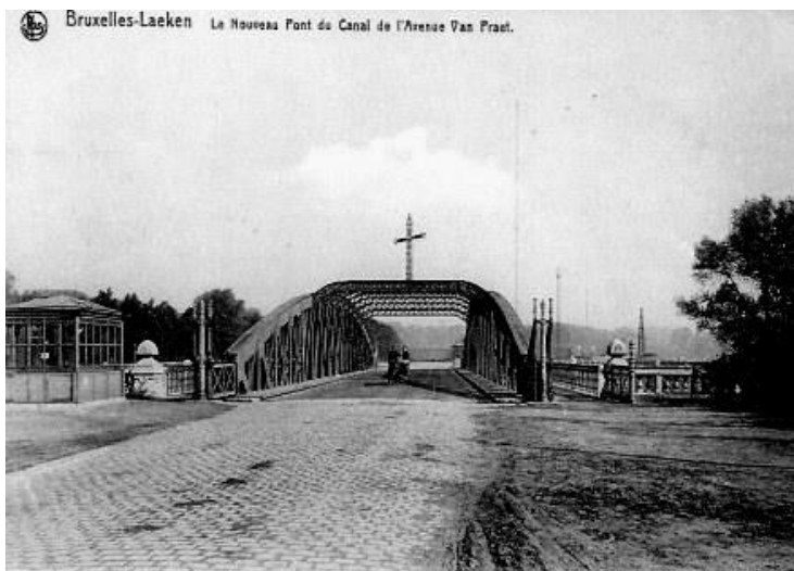
Afb. 7-10 Op de achtergrond de masten van Laken. Foto genomen vóór een vroegere Van Praetbrug, aan de overzijde van het kanaal. Foto prentkaart, archief Laca.
