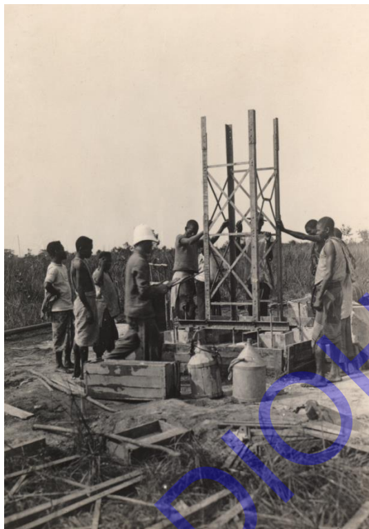
Afb. 12-4 Bouw van de antennemast te Kinshasa.
