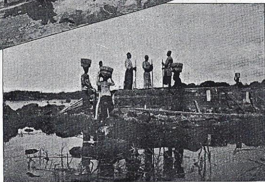
Construction de l'assise du pylône.
