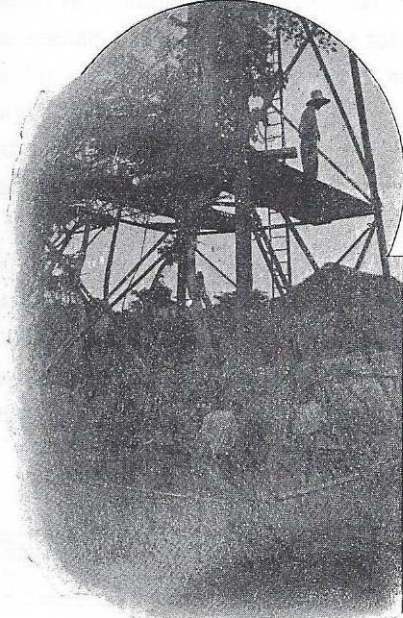
Montage d'un pylône.
