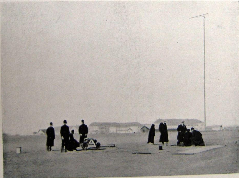
Poste de Cavalerie établissant les communications entre les Casernes de Ploesti et à Bucharest
