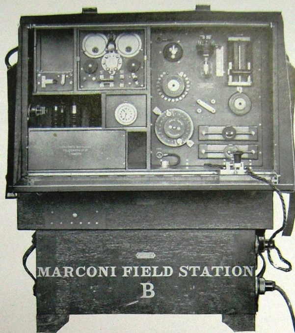
Poste de Cavalerie : Appareils de Transmission et de Réception
