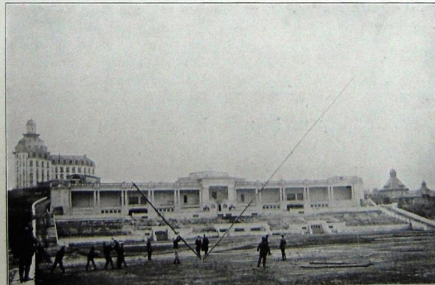
Erection du Mât pour le Poste sur Voiture Automobile à Namur (Belg.). Février 1912
