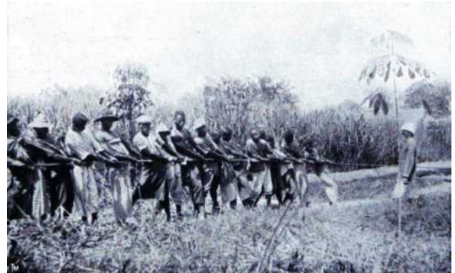
Afb. 143 Het rechtekken van een houten mast, onder het toezicht van de heer Desirotte, monteur. (Victor Boin, La T.S.F. au Congo Belge, 1913)
