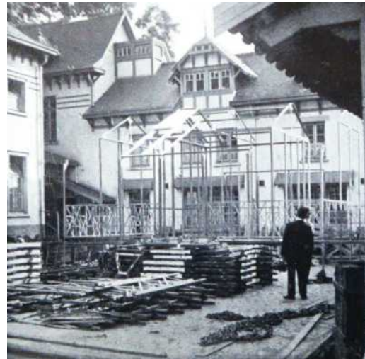
Afb. 137 Testmontage van een huisje voor Kongo, op de binnenplaats van de school. (Victor Boin, idem . cliché Schmit)
