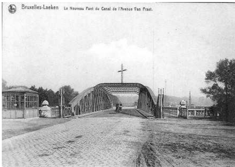
Afb. 166 Op de achtergrond nogmaals de antennemasten van Laken. Hier getrokken vóór de oude Van Praetbrug, aan de overzijde van het kanaal. (Foto prentkaart, archief LACA)
