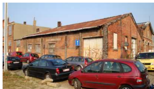
Afb. 82 Het oudste magazijn van de Red Star line. (eigen foto)
