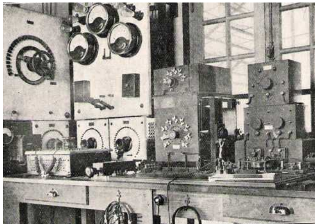
Afb. 141 De grote zender-ontvanger van de post van Kinshasa (type Laken). ( Goldschmidt et Braillard, op. cit. p 64)
