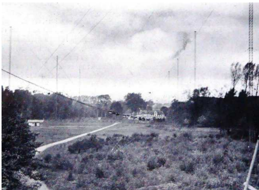
Afb. 167 Een laatste foto van de antennemasten van Laken. Op de achtergrond de villa Í Lacosteî. (Victor Boin, Bruxelles-Boma par la T.S.F., novembre 1913)
