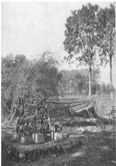
Afb. 173 Een vernietigde antennemast. (Uit 1914 Illustré, août 1914)
